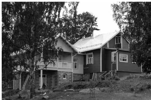
Kuva Rouhialankadun varren talon laajennustyömaasta.
