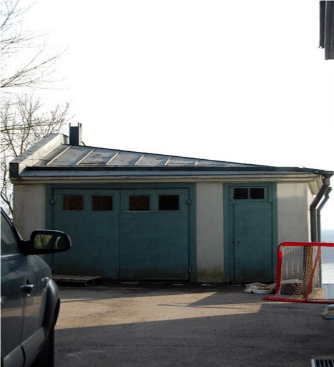
Kuva 13: Tämä autotallirakennus sopii hyvin Pispalaan.
