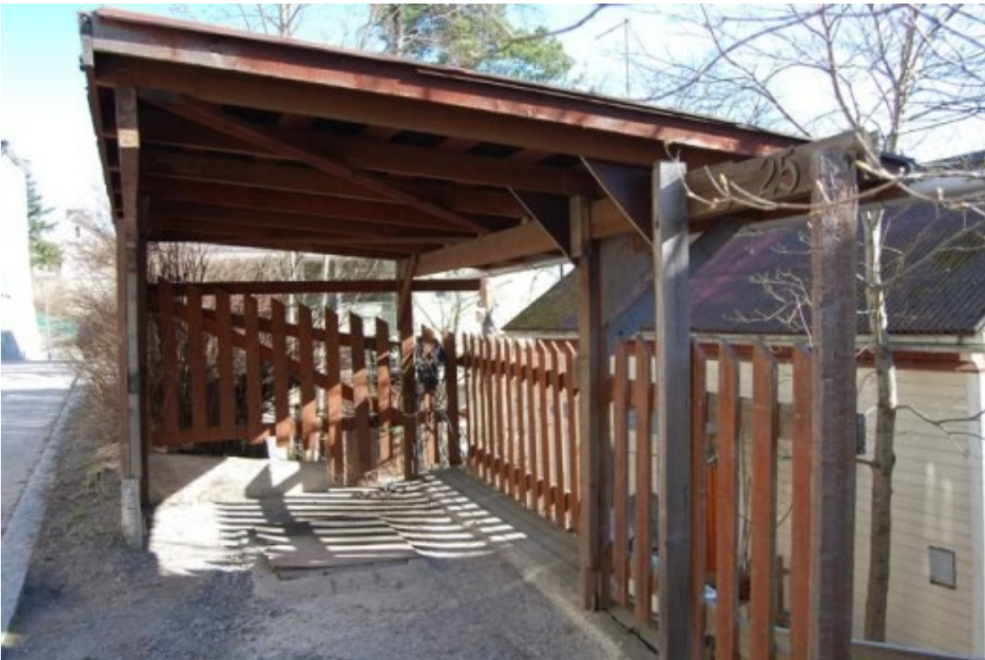
Kuva10. Tällainen hieman vaatimattomampi autokatosratkaisu Provastinkadulla sopii ympäristöönsä huomattavasti paremmin kuin esim. kuvassa 7 esitetty ratkaisu. Huom: tämän kuvan autokatoksen korkeus oli hyvin matala (suurin piirtein kierrokselle osallistuneiden korkuinen!).
