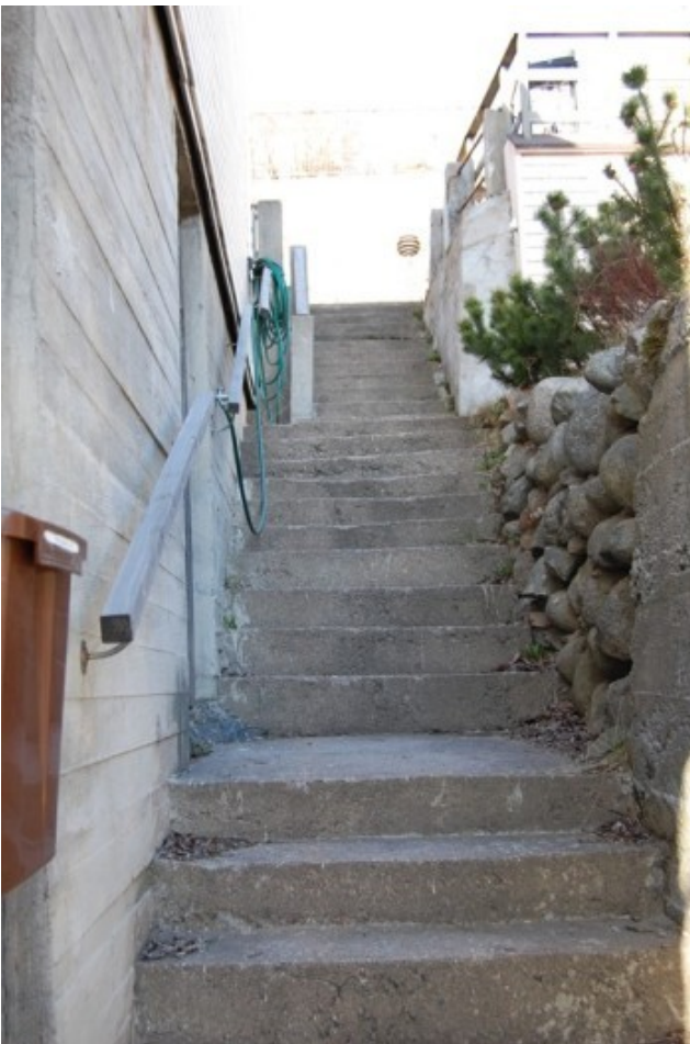
Kuva 6, 7 & 8. Betonirakentamistakin voi tehdä monella tavalla. Mielestämme nämä edustavat onnistuneita ratkaisuja. Kuvat on otettu Provastinkadulla ja Varalankadulla. Aika patinoi betonirakenteita. Lisäksi betonipintoja voi elävöittää ikkunoilla/rappauksilla jne.
