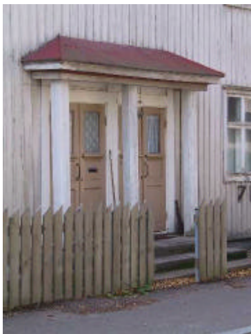
Esimerkki hyvin säilyneestä rakennuskohteesta Pättäränkadun alueella.
