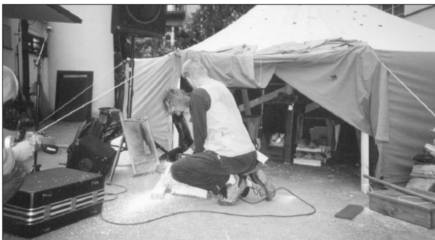
Mako ja Tomppa pystyttävät sauna Kino Aeron pihalla.
