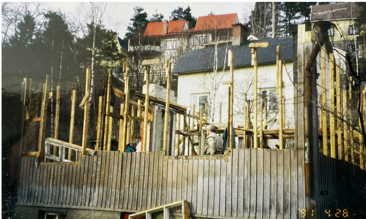
Isä Risto Raikamo purkutöissä. Isä kuvasi purkuprosessin myös videokamerallaan.
